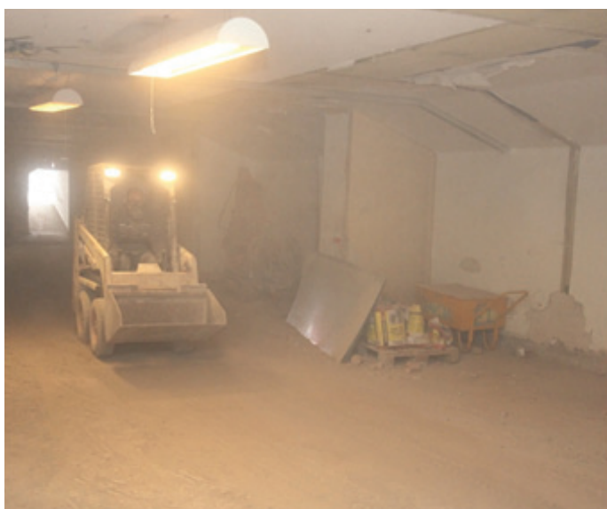
Pölytilanne kun tila on tyhjennetty rakennusjätteestä.
