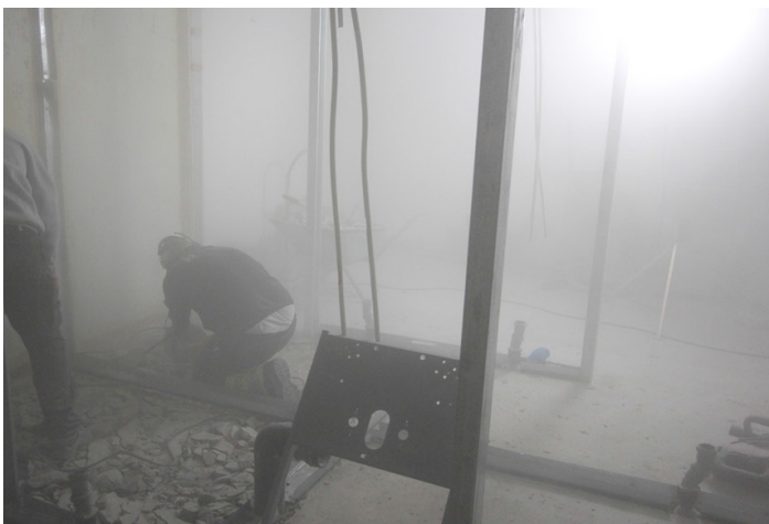
Likaantunut ilma betonilattian veistämisen ja leikkaamisen jälkeen.
